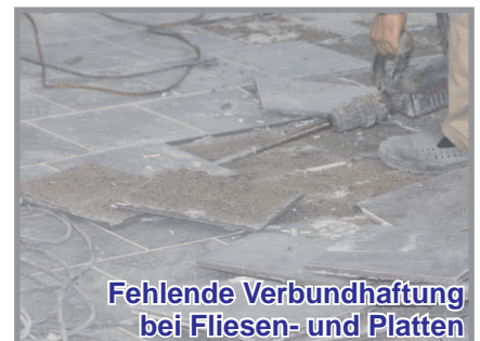
Belagsablösung aufgrund von „Klebstoffverseifung“
